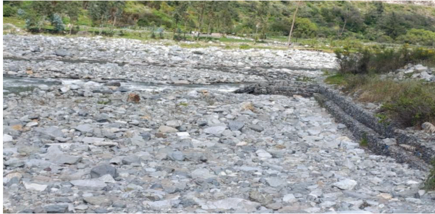
IMAGEN 2.- SOCAVACIÓN DE LA ESTRUCTURA DE PROTECCION DE LA MARGEN DERECHA.
